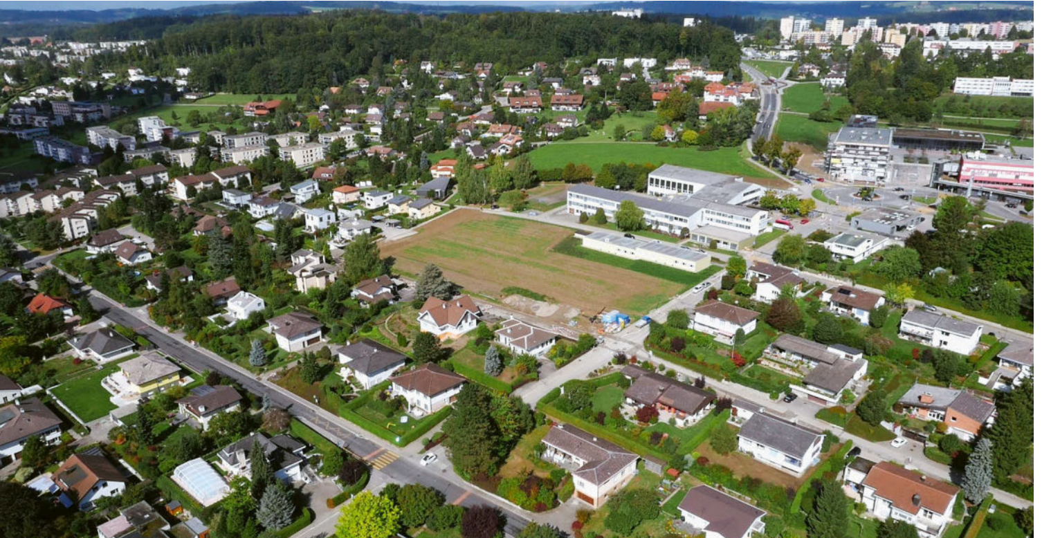
A Villars-sur-Glâne, les autorités souhaitent accompagner l'augmentation des indices de construction de mesures pour activer du nouveau potentiel (vue sur le Quartier de Cormanon). C'est ici qu'a lieu le pilote pour la stratégie Metmamorphouse. Photo: www.vision-air.ch
